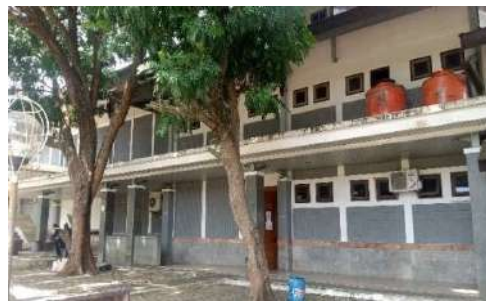
Gambar 3.7 Pintu Keluar Pengunjung Teater Sumber: Dokumentasi Pribadi, 2025
