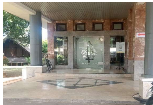
Gambar 3.5 Pintu Masuk Lobi Sumber: Dokumentasi Pribadi, 2025
